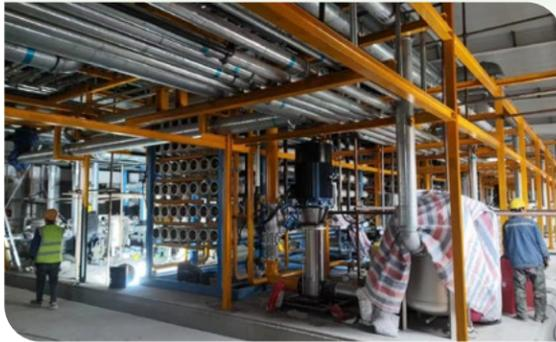
中色锌业废水综合治理项目采用“物化综合+超滤+反渗透+MVR蒸发分盐”工艺,通过对生产废水深度处理、循环利用达到废水零排放的目标。
