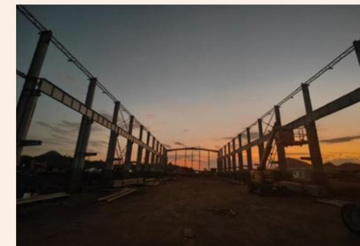
印尼阿曼项目电解车间钢结构安装
