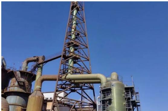
中色锌业完成总厂制酸尾气提标改造工程，升级增设碱液喷淋和电除雾废气治理设施，确保制酸系统在启停炉作业过程中污染物符合《铅、锌工业污染物排放标准》要求
